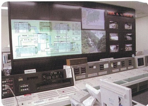
水库大坝调度室(日本·群馬县、藤原水库)
