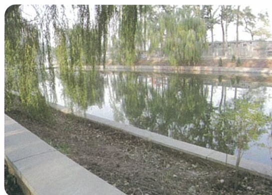
京密水渠—给北京市民提供生活用水
