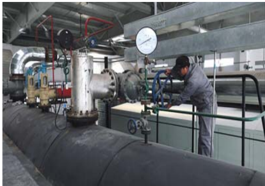
检查供热管道（实施单位供图）
