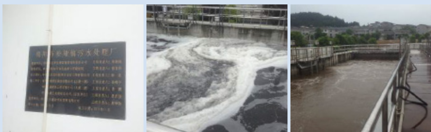
绵阳市松娅镇 污水处理厂
