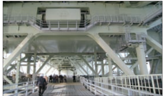
图2 现场调研明石海峡大桥的养护管理情况
