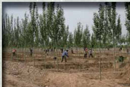
宁夏回族自治区重点风沙区 环境综合治理项目(日元贷款)
