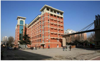
本事業で建設された校舎
