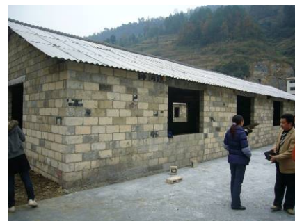
建設中の共同養豚場
