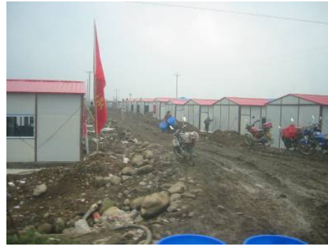
1万戸の仮設住宅が急ピッチで建設中(綿竹市)
