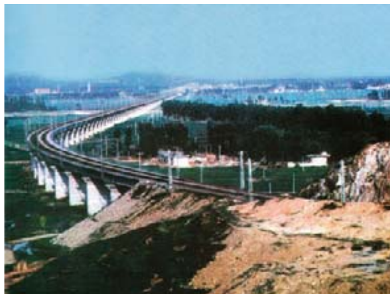
北京—秦皇岛间铁路扩建项目 (北京、日元贷款)： 为了解决山西省的煤炭外运问题，在已近饱和的现有铁路之外，新建一条复线、电气化铁路。该铁路运送的煤炭，经由日元贷款扩建的秦皇岛港运往外地。
