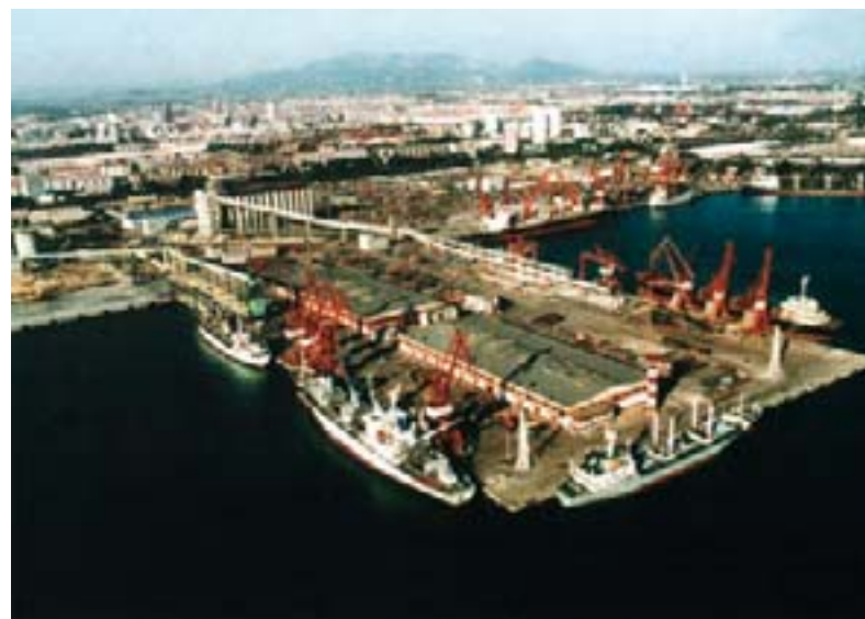
秦皇岛港扩建项目 (河北省、日元贷款)： 通过在秦皇岛港修建煤炭码头，加强了山西省的煤炭运输能力。之后又建设了木材、粮食、杂货码头等，增加了秦皇岛港的货物运输量，成为中国经济发展的基础。
