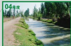
新疆维吾尔自治区伊宁市环境综合治理项目
