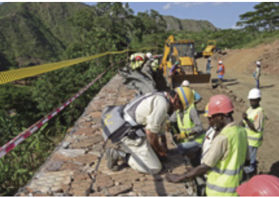
国境手続円滑化施設整備工事(photo:JICA/Takeshi Kuno)
