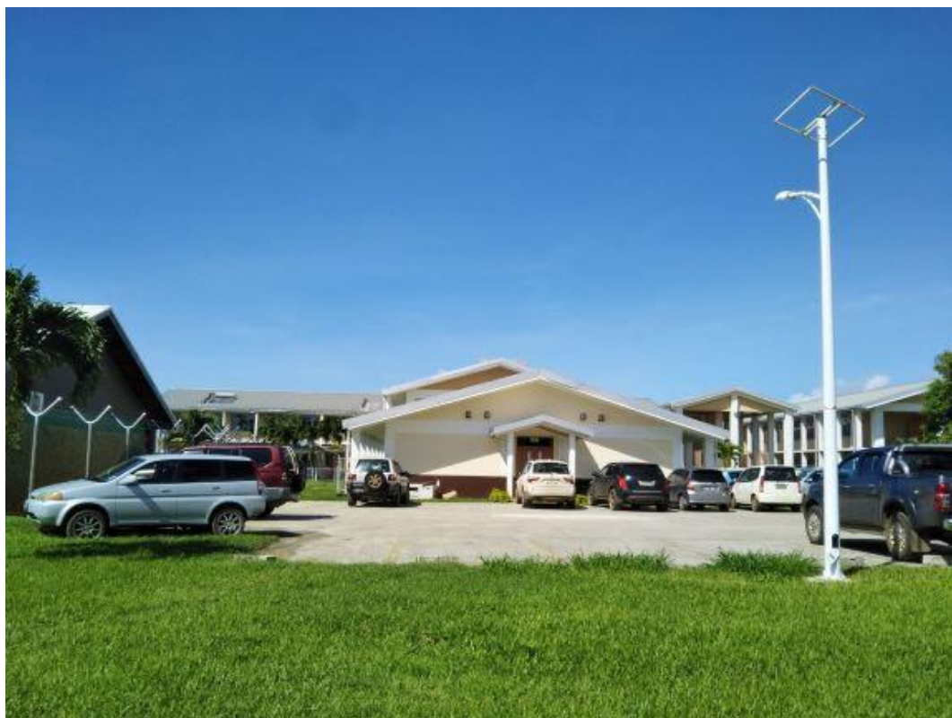
遠隔ICUコンテナ病棟等の設置現場の写真
