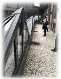
盲道線のみ施工 ※斜面部は合わせガラス (膜物フィルム圧着済) につきフィルム不要
