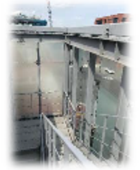
階段室内部は吹きさらし(屋根なし)のため、外部用フィルムを外側から施工
