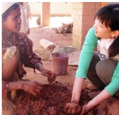
⑤ ねんど あかつち かたまり 粘土や赤土の塊がな いくらいによく混ぜたら、 OK!
