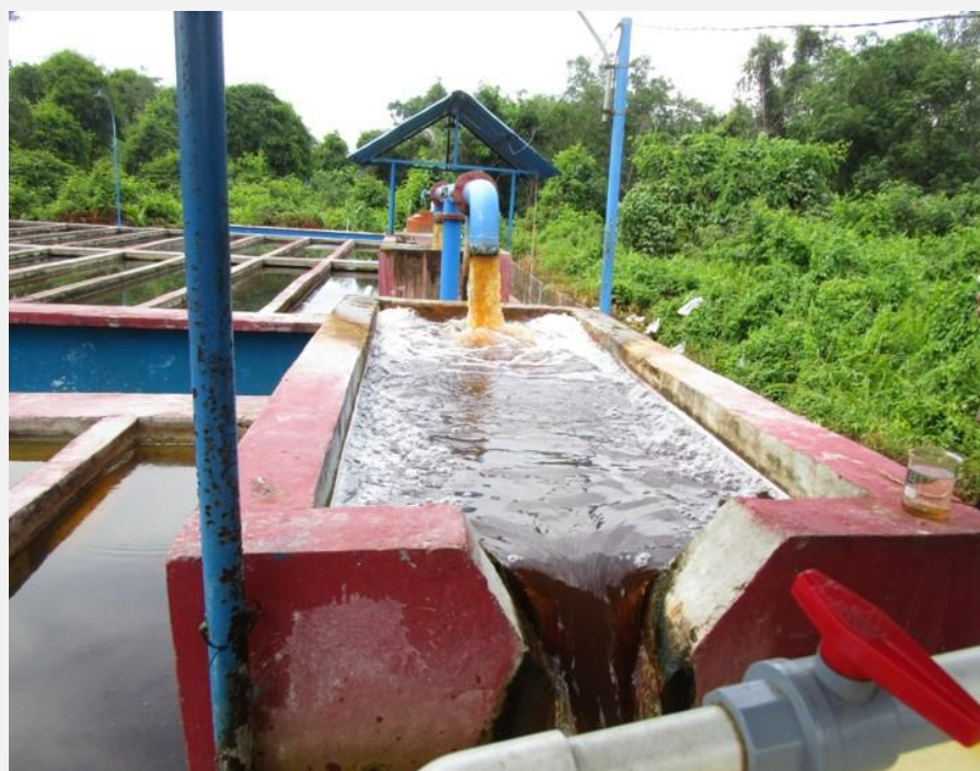
泥炭の影響で色が付いた原水。薬品を入れて異物を沈殿させた後、ろ過する
