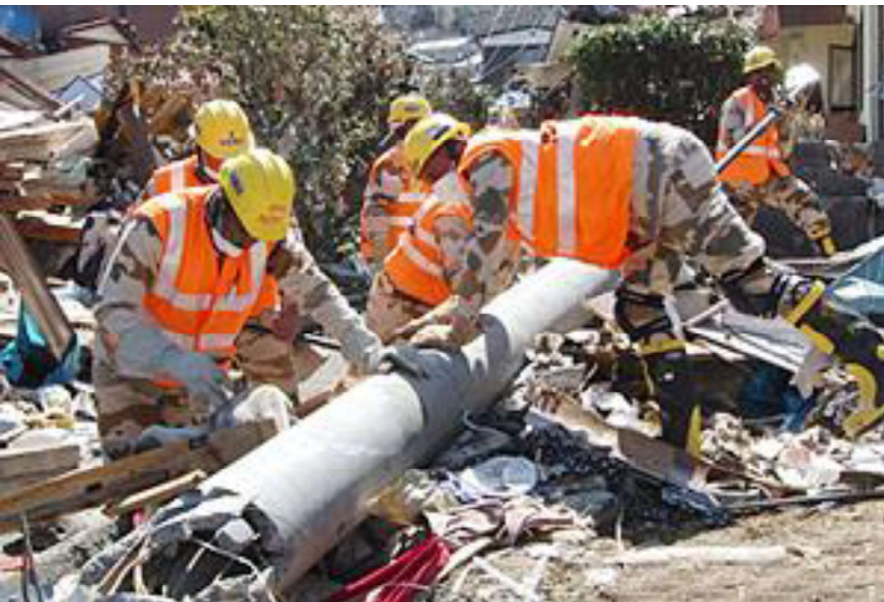
電信柱撤去作業を行う インド隊員
