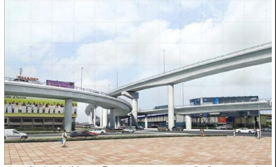
無償資金協力「日本・コートジボワール友好交差点」(施工中)
