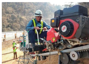
ネパールの工事現場にモノラックを設置して実証試験をする様子
