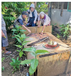
村に設置されたバイオガス視察
