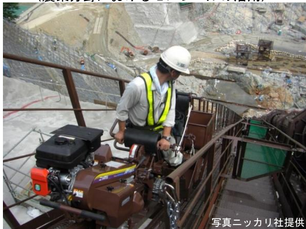
写真ニッカリ社提供 (工事現場におけるモノレールの活用)
