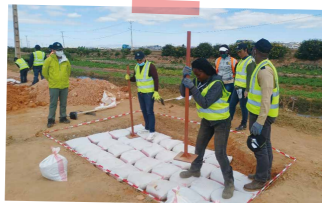
マダガスカルでの土のうを用いた路面強化実習の様子
