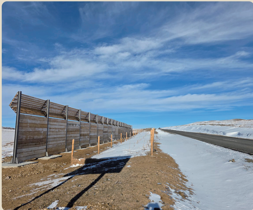
▲ウランバートル近郊の国道に全長60mの木製防雪柵を設置し効果を実証中。
