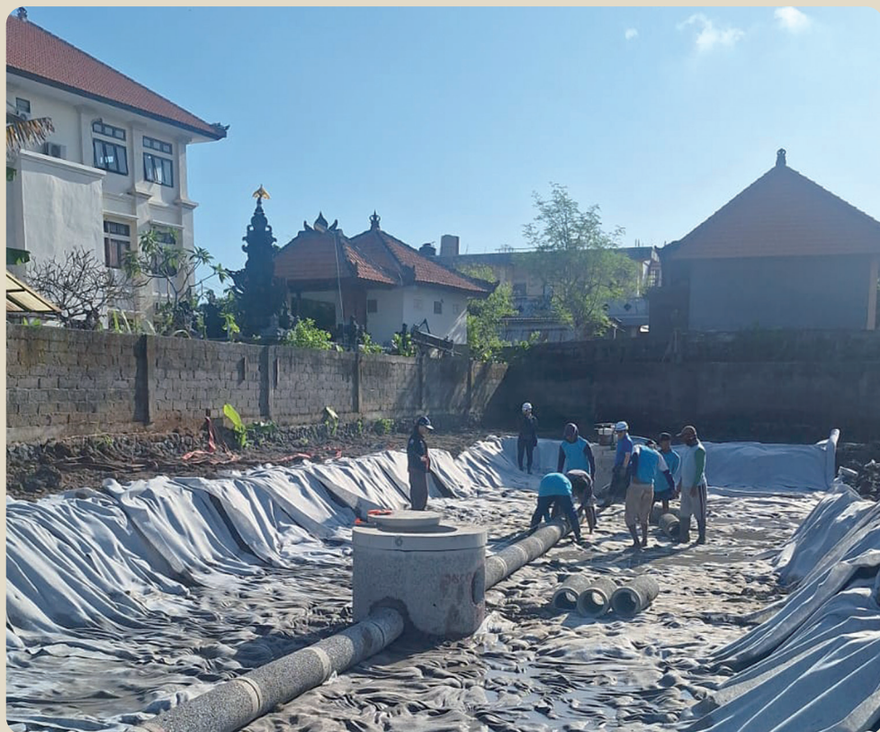
▲デンパサール中学校校庭に浸透井戸とポーラス管を設置
