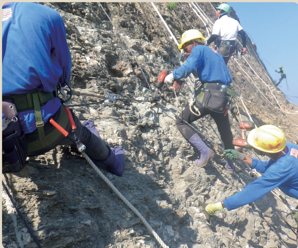
▲現地作業員との道路斜面对策工事の様子
