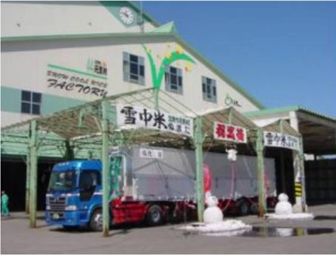
スノークールライスファクトリー(米の貯蔵に雪冷房を導入した施設)
