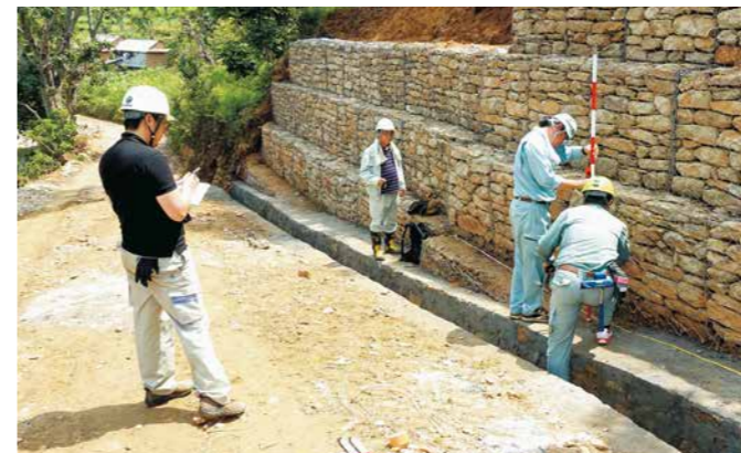
現地での蛇籠設置現場
