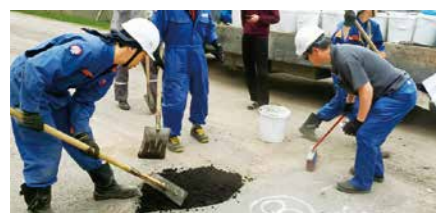
現地での施工風景
