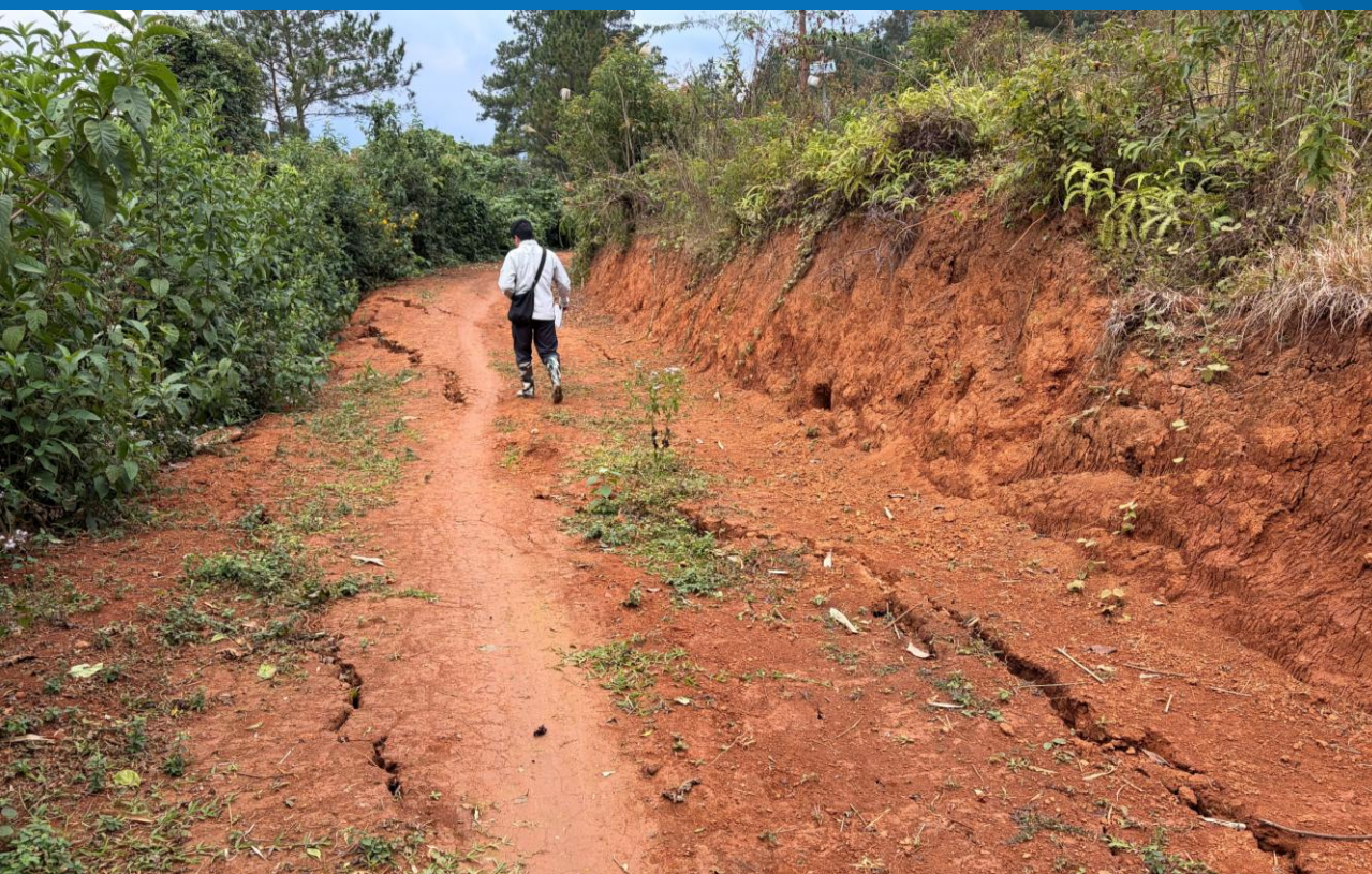
【民間連携事業】<ベトナム>地すべり現場の視察 (奥山ボーリング株式会社)
