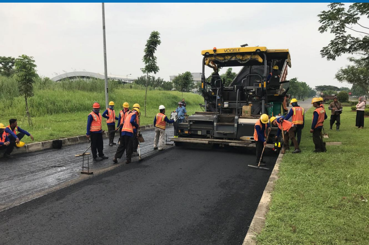
【民間連携事業】<インドネシア>リサイクルアスファルトを用いた道路舗装作業の様子(菅原工業・宮城県気仙沼市) 「アスファルト廃棄物を活用した循環型舗装技術に関する普及・実証・ビジネス事業」
