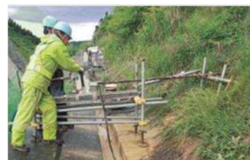
地すべり応急対策（斜面排水）の様子
