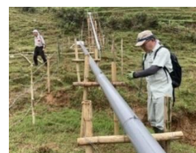
地盤伸縮計の設置の様子
