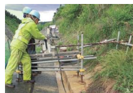
簡易水抜き工法実施の様子
