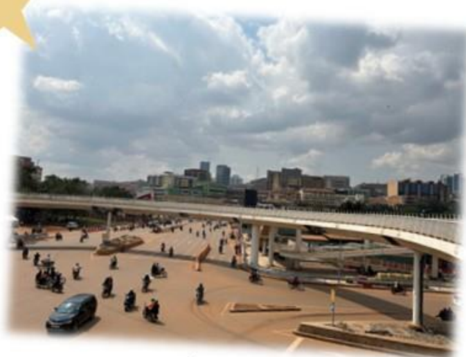
カンパラ立体交差建設・道路改良事業
