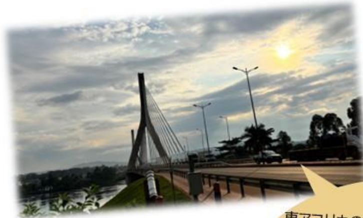
ナイル架橋建設事業
