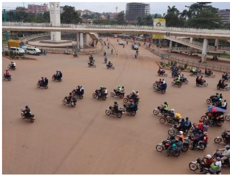
カンパラ立体交差(フライオーバー)
