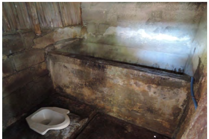
【トイレ・水浴び場】トイレは東ティモール仕様。大きなタンクに水をたっぷり貯めておけるので断水時も安心して水浴びできます。
