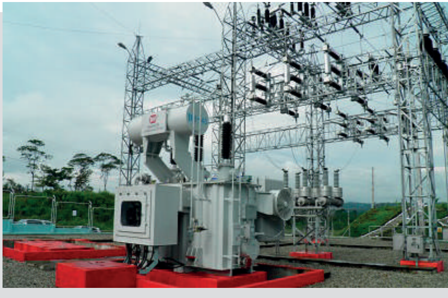
Ejemplo de la infraestructura a ser financiada por este Proyecto.
