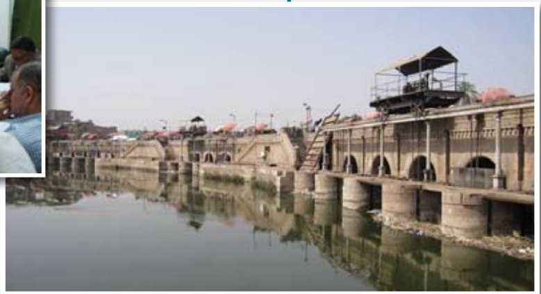
منظر عام لقناطر ومنظمات مياه الري بديروط Overview for Dirout Group of Regulators
