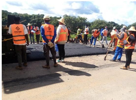
Transport du béton bitumineux et mise en oeuvre
