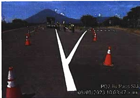
Fig. 9: Dispositivo de seguridad vial para actividad de colocación de pintura termoplástica. Est. 4+510. 09-09-2023.
