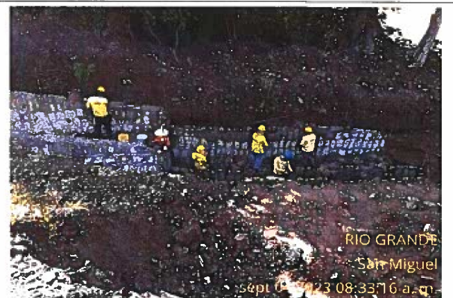
Fig. 6: Mampostería de derramadero VD-1, estribo A-2, Est. 5+189 04-09-23
