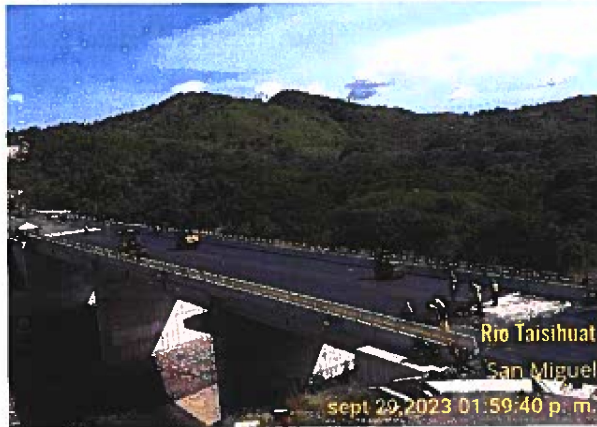
Fig. 9: Mezcla asfáltica modificada Est. 9+391 - 9+496. 29-09-2023.
