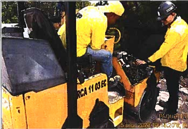
Fotografía 7: Inspección de seguridad conjunta previa a la admisión de un equipo ligero de compactación. Plantel del contratista. 05-09-2023.
