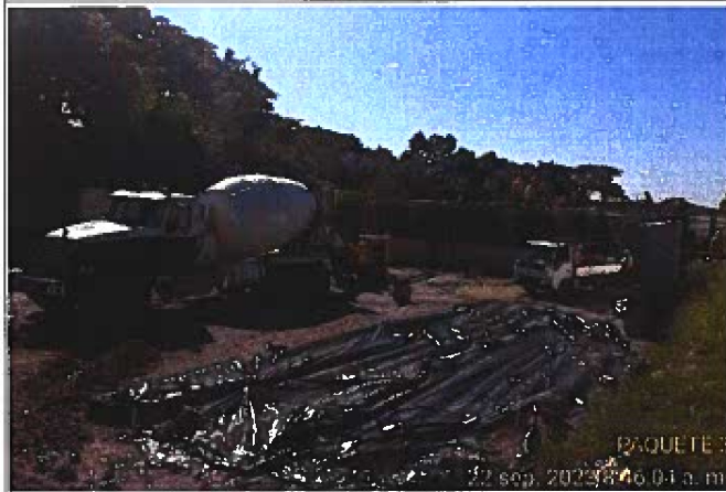
Fotografía 3: Colado de concreto en diafragma de estribo de entrada del puente sobre río El Papalón Est. 15+100. 22-09-2023
