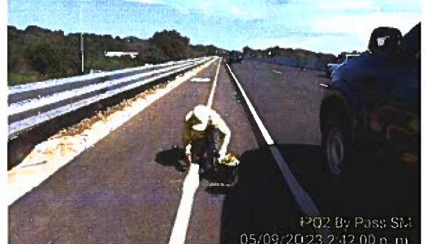
Fig. 2: Colocación de vialetas en Est. 8+500 LI en área de ciclo ruta. 05-09-2023.
