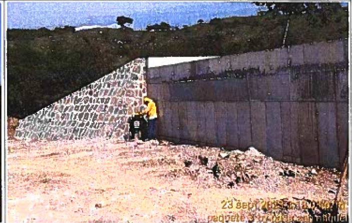
Fotografía 4: Compactación de relleno estructural en zona de paso de ganado en Est. 11+006. 23-09-2023.
