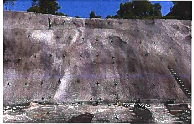
Fig. 2: Concreto lanzado en talud, Est. 5+585 - 5+613 LI. 05-09-2023
