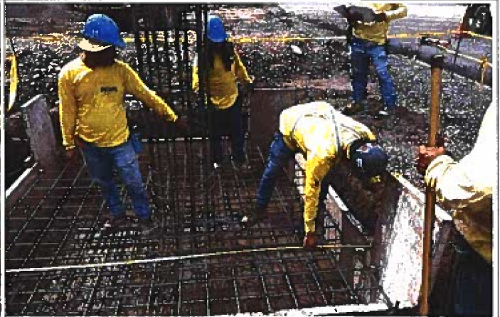
Fotografía 2: Construcción de zapatas de paso peatonal elevado de Est. 8+668. 21-09-2023.
