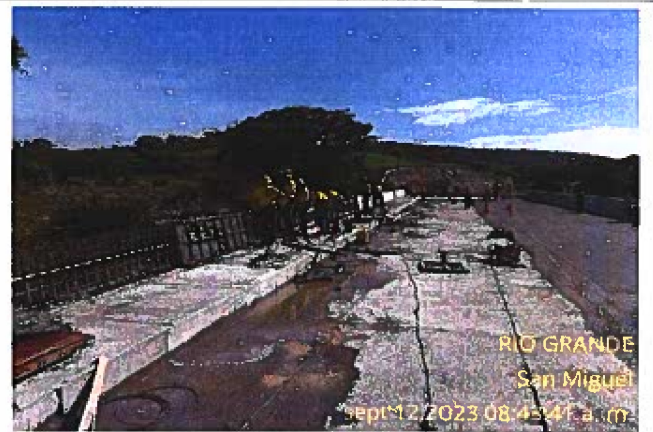
Fig. 4: Encofrado de barrera externa sobre puente, lateral izquierdo 12-09-2023
