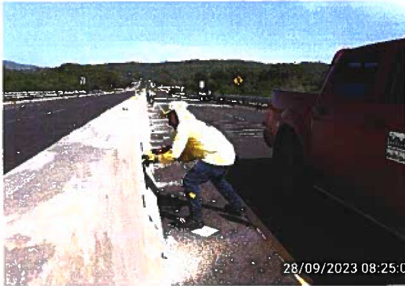
Fig. 7: Colocación de ménsulas en separadores entre Est. 7+900 a 8+300. 28-09-2023.
