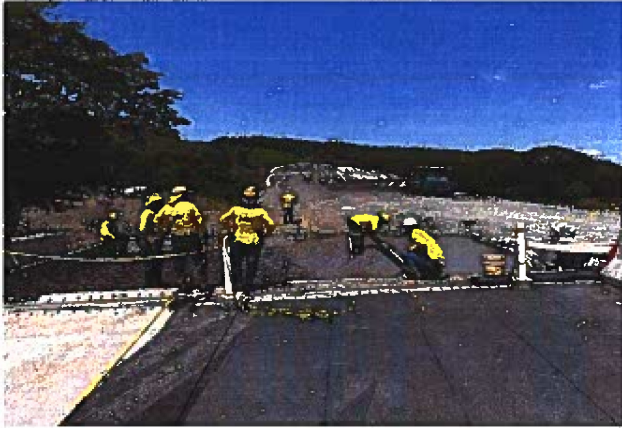
Fig. 1: Colado de losa de aproximación, lateral izquierdo, estribo de salida 11-09-2023
