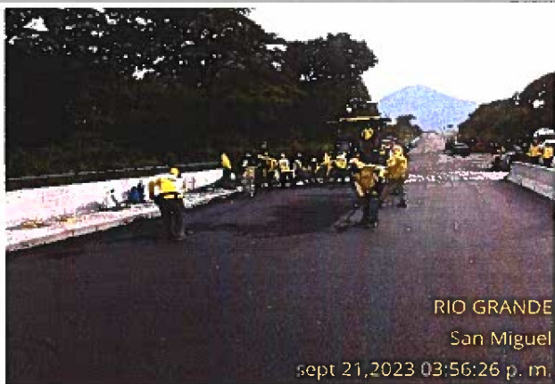
Fig. 5: Mezcla asfáltica modificada, ambos carriles laterales derecho del puente 21-09-2023
