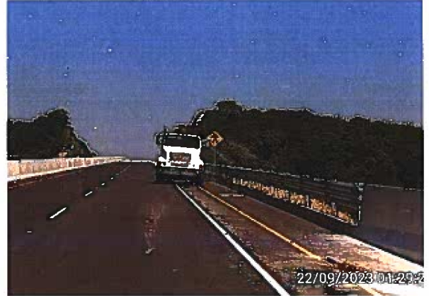
Fig. 8: Riego en talud Est. 6+100 a 6+300 LD. 22-09-2023.
