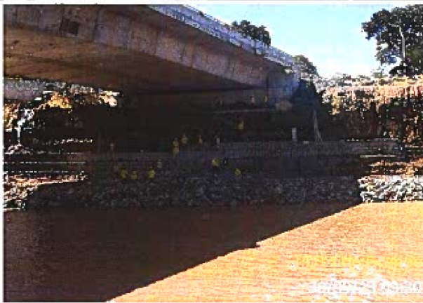
Fig. 3: Construcción de muro gavión, estribo A-1. Parte central 30-09-2023.
