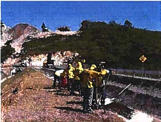
Fig. 15 Trabajadores usando el uniforme institucional y su EPP durante la instalación de guardacarriles. Aproche de salida del puente Taisihuat. 06-09-2023.
