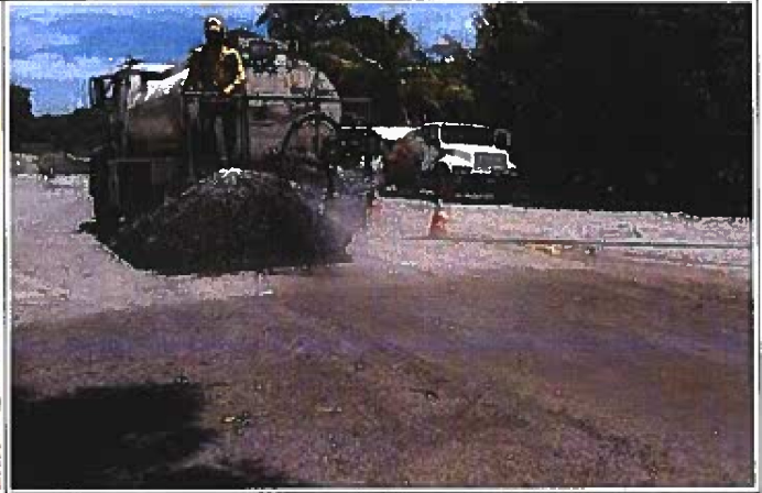
Fotografía 8: Humectación para la mitigación de polvo en el Proyecto. Est. 15+010. 07-09-2023.
