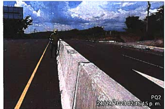
Fig. 4: Inspección de alineamiento barreras separadoras tipo F entre Est. 8+565 a 8+580. 24-09-2023.
