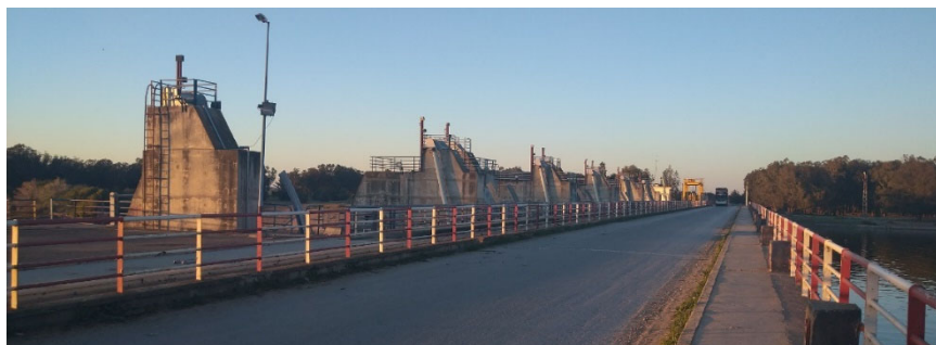
Photos : Barrage de la Garde de Sebou situé à 50km en amont de l'embouchure de la rivière Sebou (le côté gauche est en aval)
