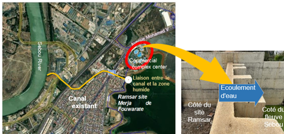
Figure 3.1.16 Canal existant reliant le Merja de Fouwarate et la rivière Sebou
