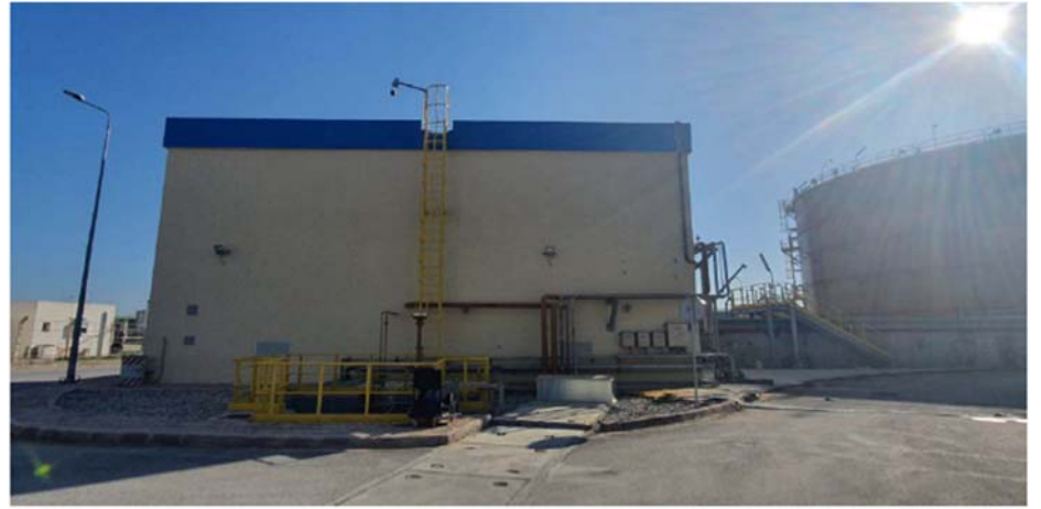
Bâtiment dépotage gasoil
