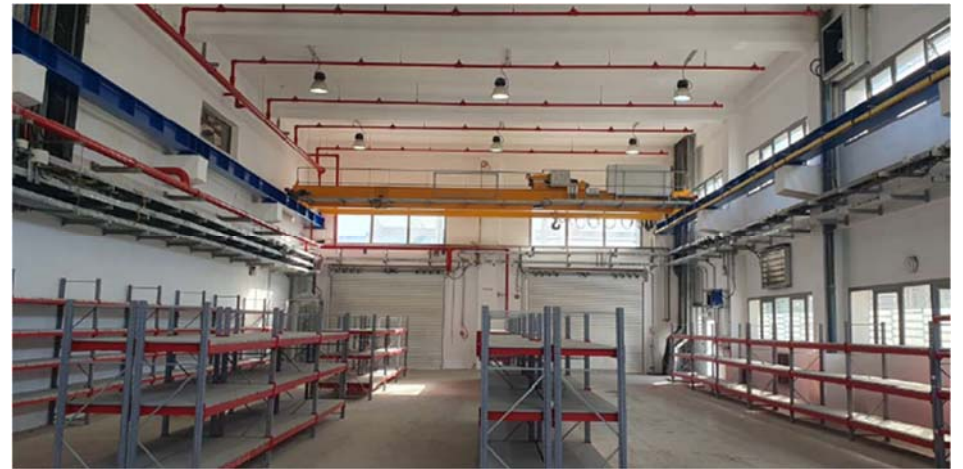
Bâtiment de la chaudière auxiliaire Dépot
