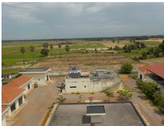
Photo1-5 : Existing WTP (June 2017)
