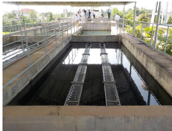
Photo1-4 : Existing WTP (June 2017)
