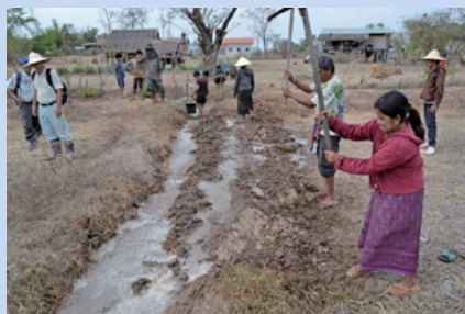
Agricultores construyendo el canal de riego
