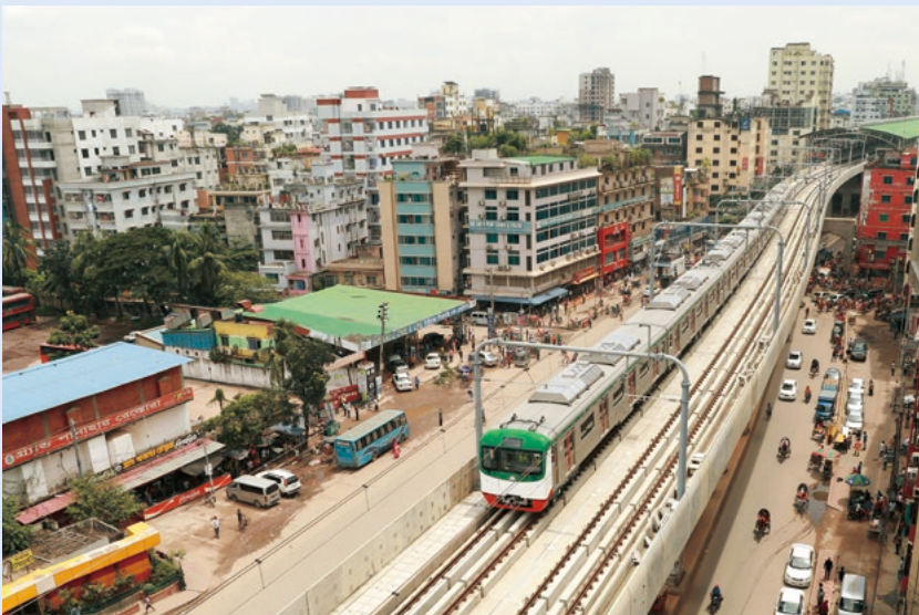
Línea 6 del Sistema de Transporte Masivo Rápido (MRT) de Daca, Bangladesh
