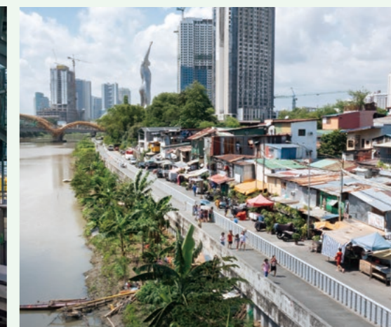
Les digues du Grand Manille, aux Philippines, construites avec la coopération de la JICA
