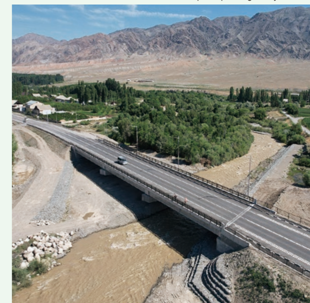
Le pont de la rivière Urmaral (Pont Sakura) reconstruit en République kirghize, juillet 2024
