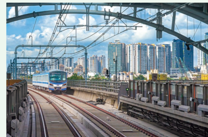
Entrée en exploitation de la ligne de métro urbain n°1 de Ho Chi Minh-Ville, qui dispose de la première section souterraine du Vietnam
