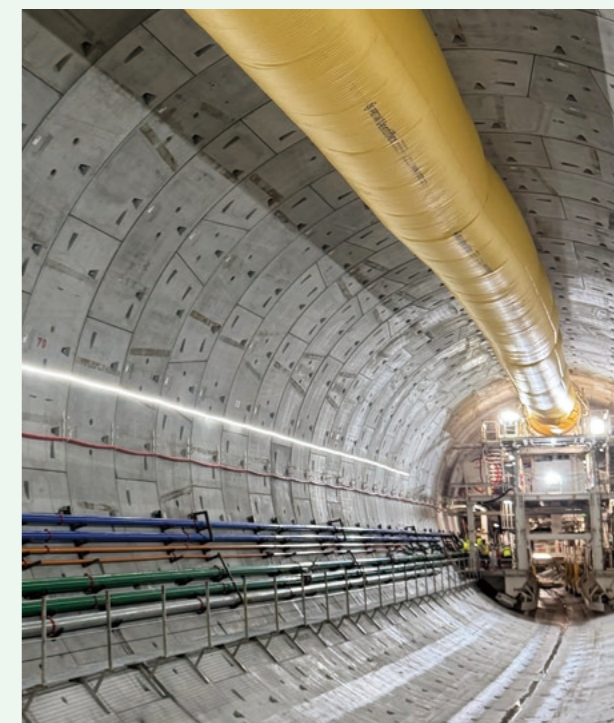
Site des travaux en cours d'un tunnel de métro au Panama
