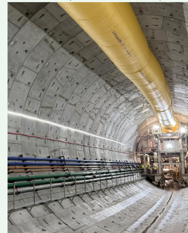
Lugar en Panamá donde se lleva a cabo la perforación de túneles con escudo para el metro
