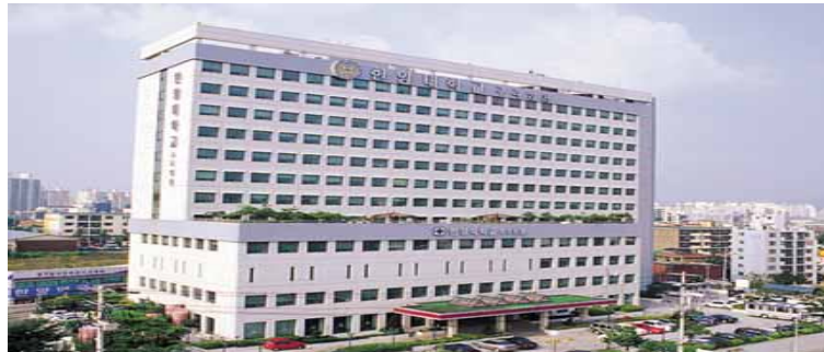
<Figure 5-6> Hanyang University (Kuri Hospital)
