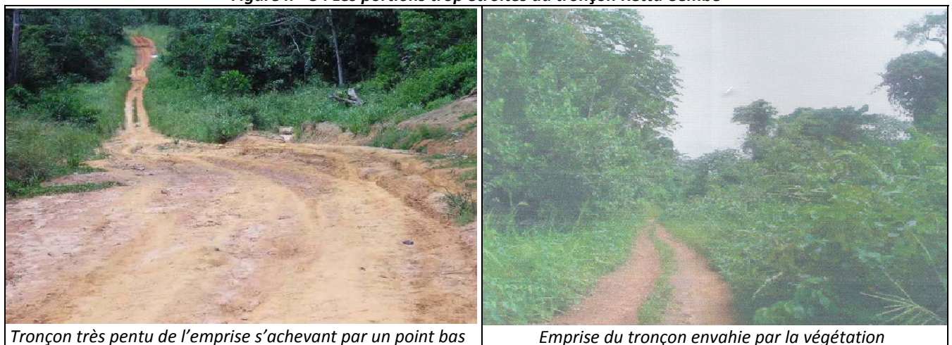
Figure n° 3 : Les portions trop étroites du tronçon Ketta-Sembé
