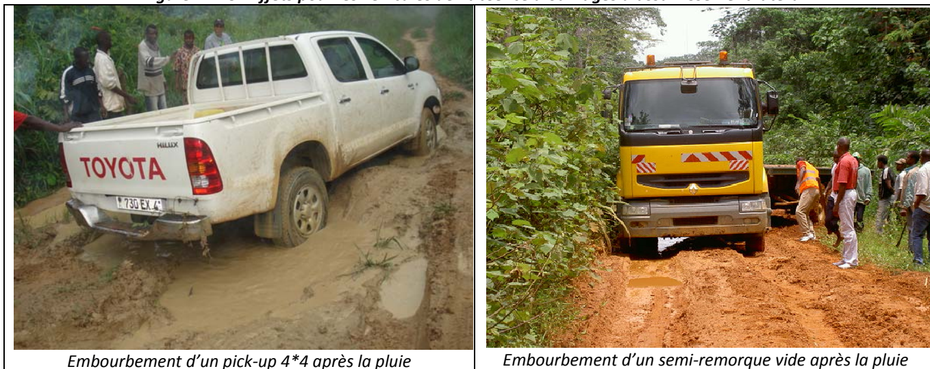
Figure n° 15 : Effets pour les véhicules de l'absence d'ouvrages d'assainissement latéral
