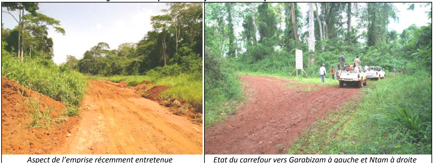
Figure n° 5 : Les portions satisfaisantes du tronçon Sembé-Bellevue
