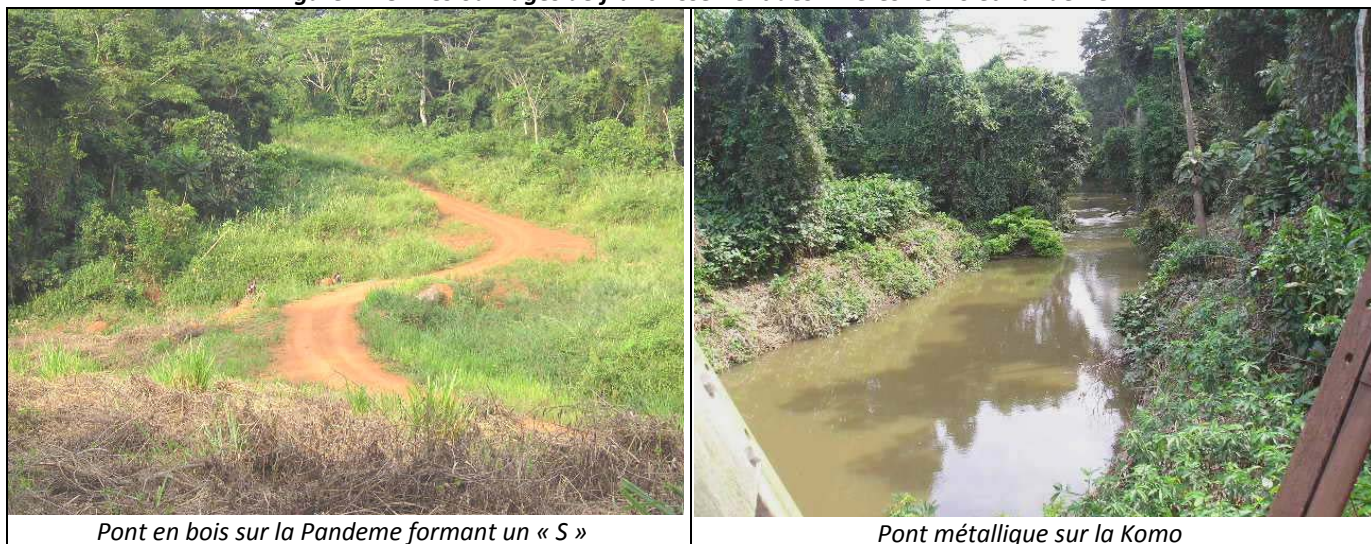
Figure n° 8 : Les ouvrages de franchissement des rivières Komo et Pandeme
