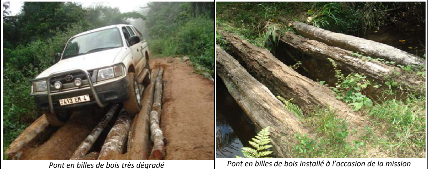
Figure n° 11 : Les ouvrages de franchissement provisoires entre Souanké et Bellevue
