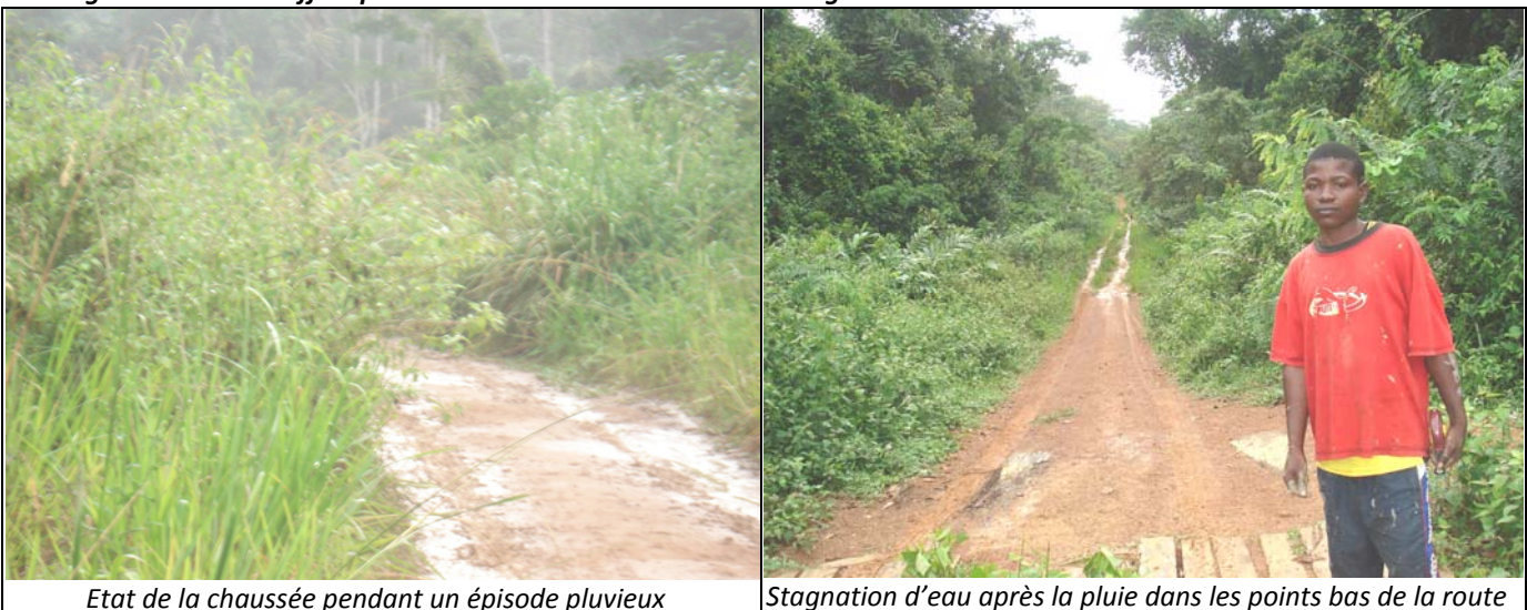
Figure n° 14 : Les effets pour la chaussée de l'absence d'ouvrages d'assainissement latéral entre Souanké et Ntam
