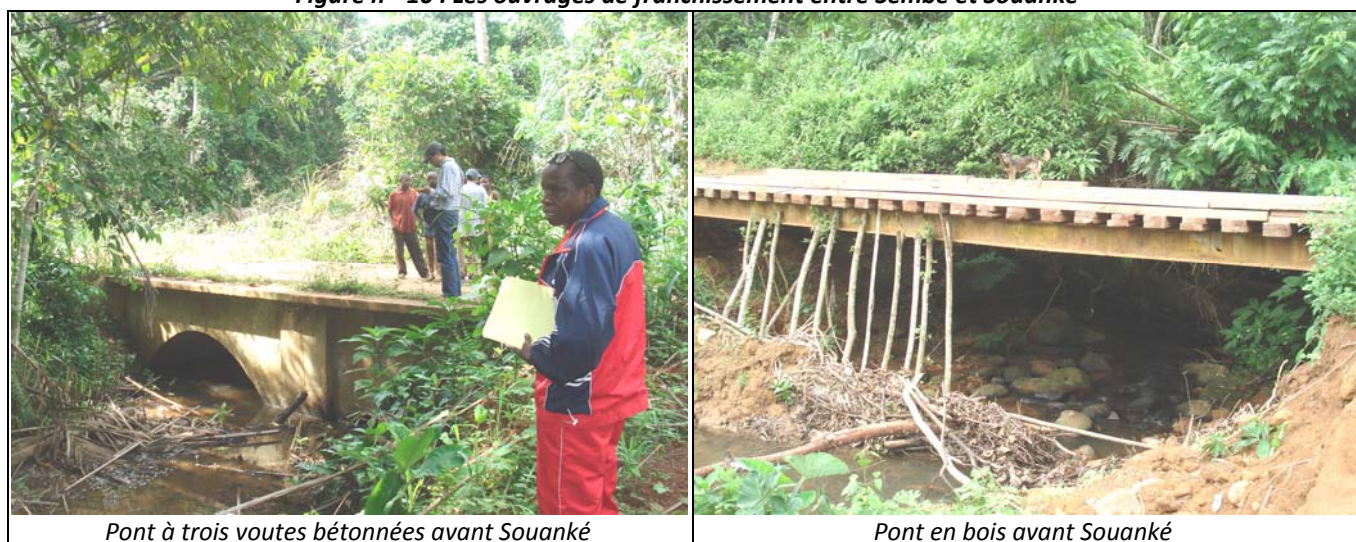
Figure n° 10 : Les ouvrages de franchissement entre Sembé et Souanké
