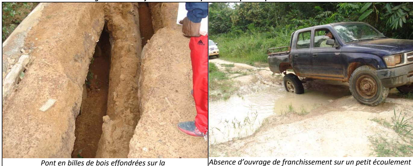
Figure n° 7 : Les franchissements problématiques de petits écoulements
