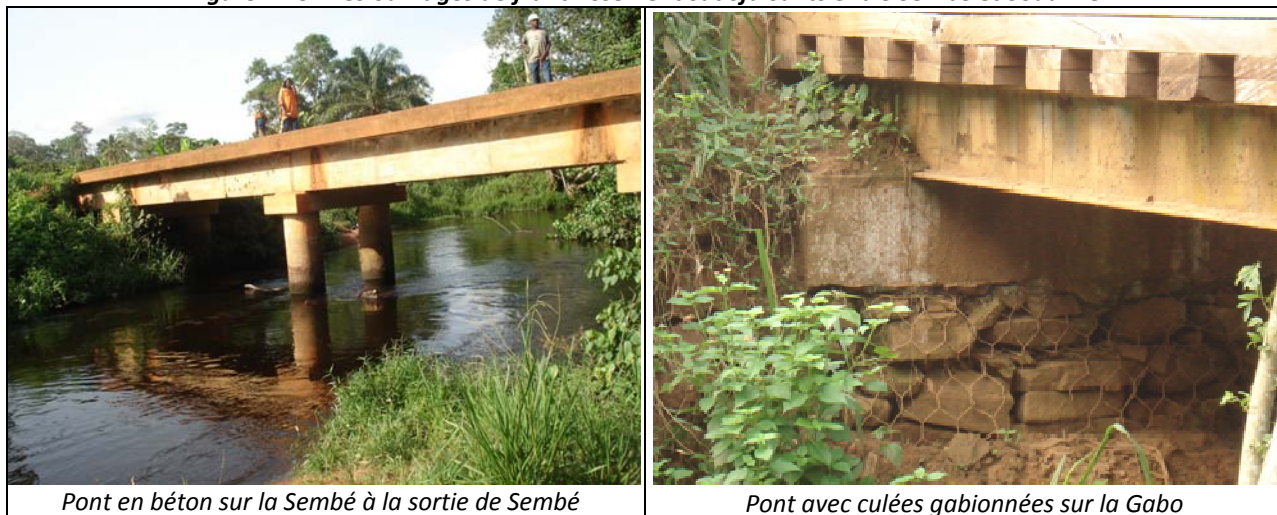
Figure n° 9 : Les ouvrages de franchissement satisfaisants entre Sembé et Souanké
