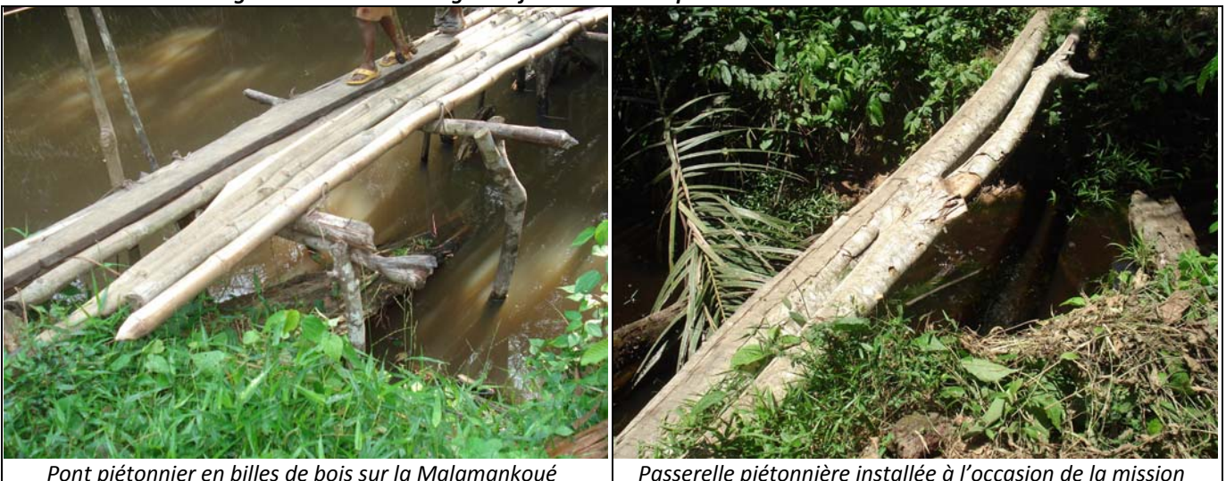
Figure n° 12 : Les ouvrages de franchissement pédestres entre Bellevue et Ntam
