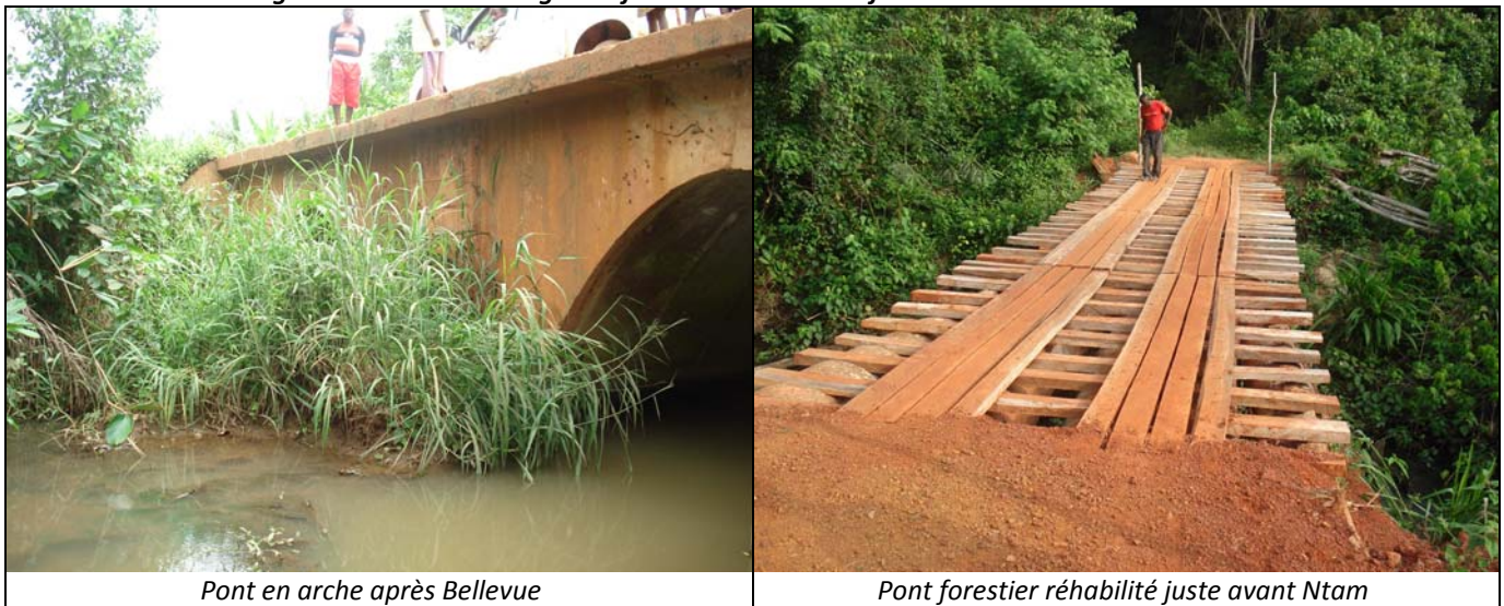
Figure n° 13 : Les ouvrages de franchissement satisfaisants entre Bellevue et Ntam
