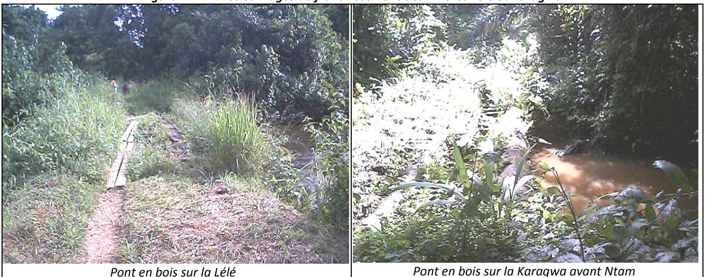
Figure n° 12 : Les ouvrages de franchissement des rivières Lélé et Karagwa
