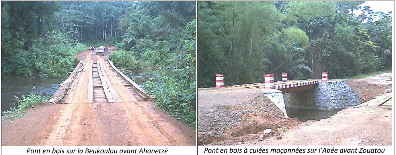
Figure n° 11 : Les ouvrages de franchissement des rivières Beukoulou et Abée
