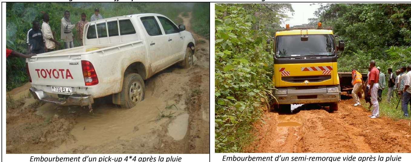
Figure n° 14 : Effets pour les véhicules de l'absence d'ouvrages d'assainissement latéral
