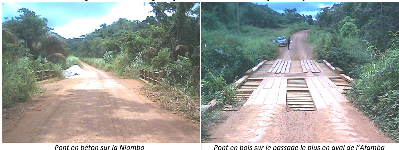
Figure n° 6 : Les ouvrages de franchissement des rivières Njombo et Afamba
