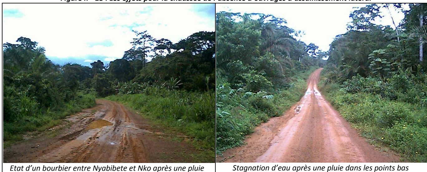
Figure n° 13 : Les effets pour la chaussée de l'absence d'ouvrages d'assainissement latéral
