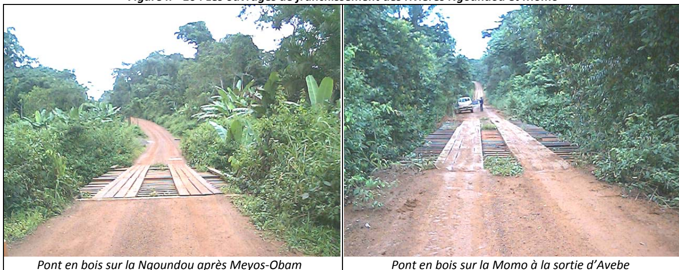
Figure n° 10 : Les ouvrages de franchissement des rivières Ngoundou et Momo
