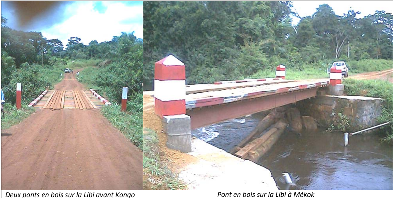
Figure n° 8 : Les ouvrages de franchissement de la rivière Libi
