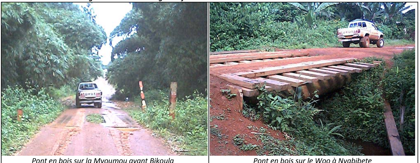
Figure n° 9 : Les ouvrages de franchissement des rivières Mvoumou et Woo
