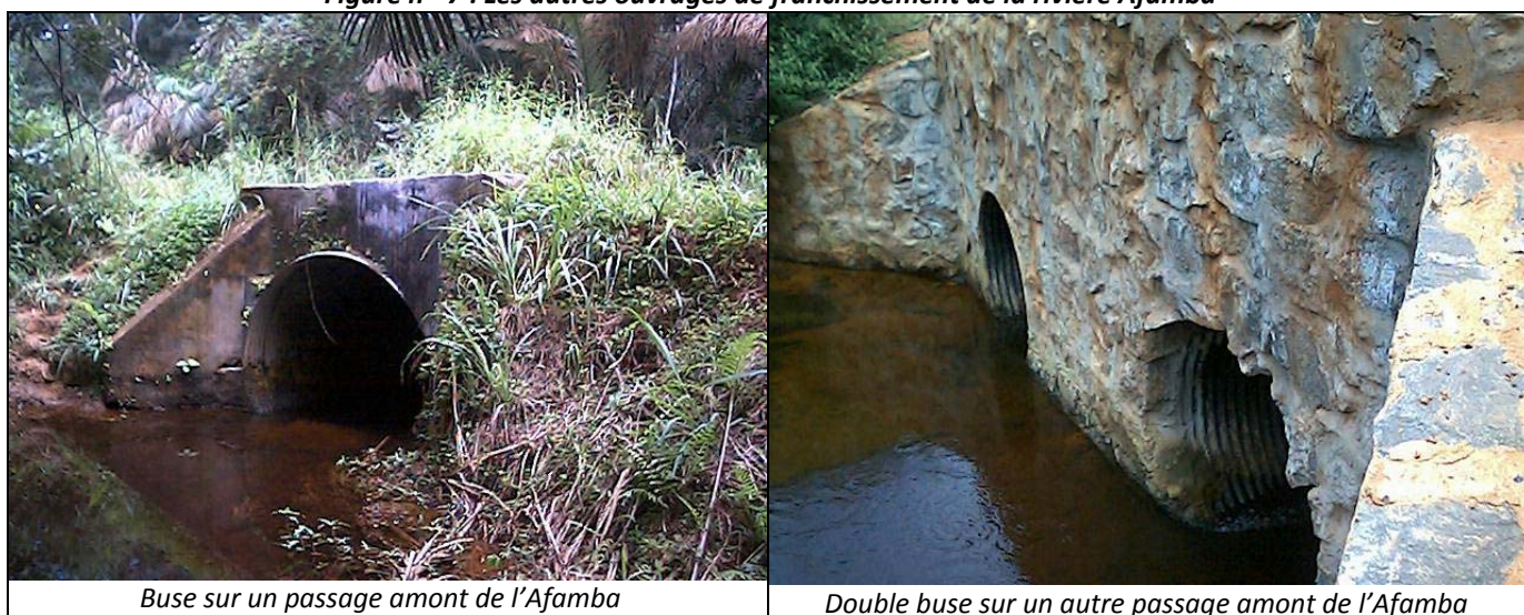
Figure n° 7 : Les autres ouvrages de franchissement de la rivière Afamba
