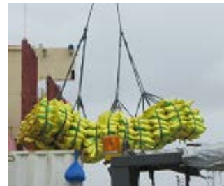
図 2.1-9 吊荷姿 D 300 バッグ (15 バッグ x 2 列 x 5 セット x 2 組) 重さ 15 トン
