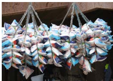
e) ライスバッグ1組の吊り上げ
