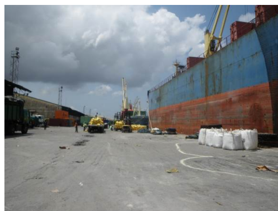
写真(2) 岸壁と倉庫
