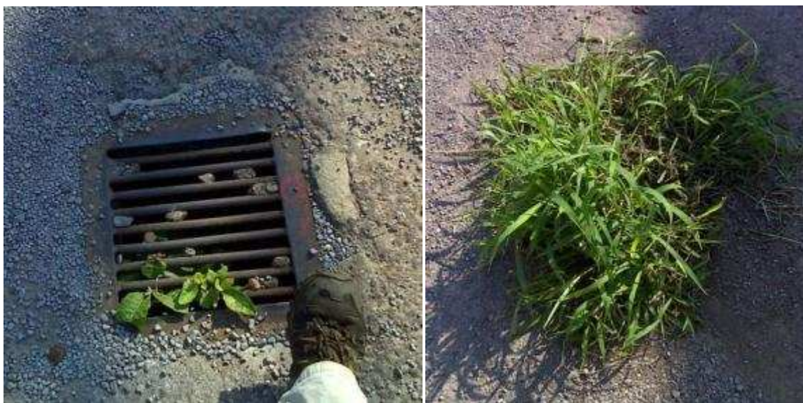
Figura 24: Drenos obstruídos no local da CTM.
