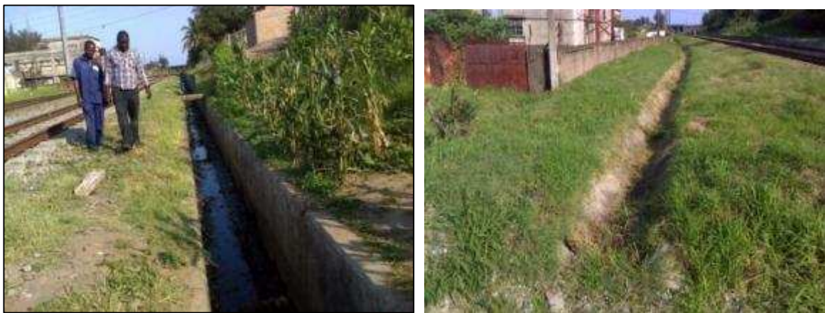
Figura 21: Canal de drenagem de águas pluviais: a) a norte da linha férrea; b) a sul da linha férrea.
