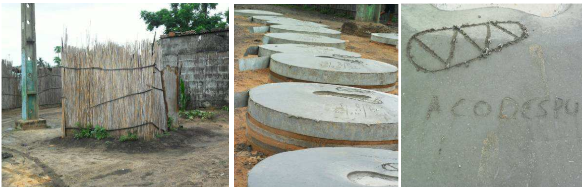
Figura 46: Latrina tradicional na área do projecto; produção de lajes de cimento pela ACODESPU.
