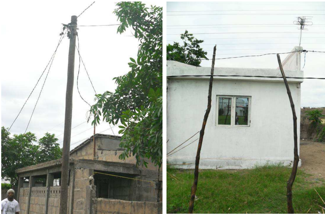
Figura 45: Posto de energia eléctrica e antena de televisão no quarteirão 40a.
