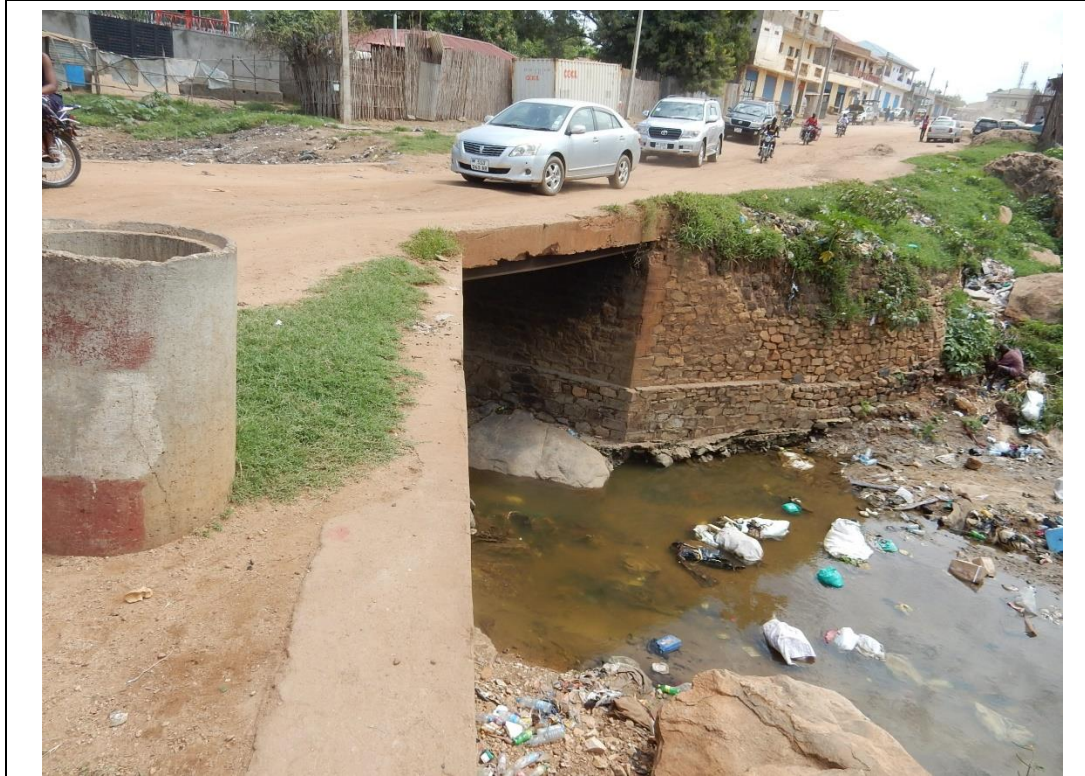
橋台付近（右岸下流側）から望む
