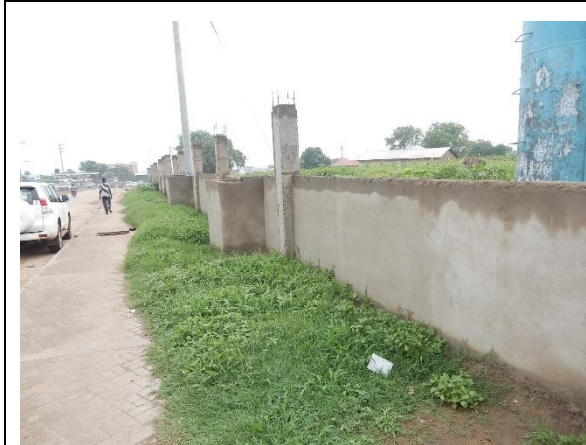
塀が建設された仮設ヤード
