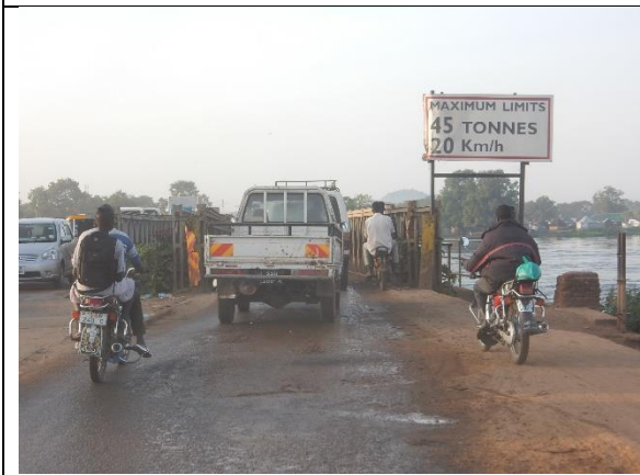
旧ジュバ橋の現況
