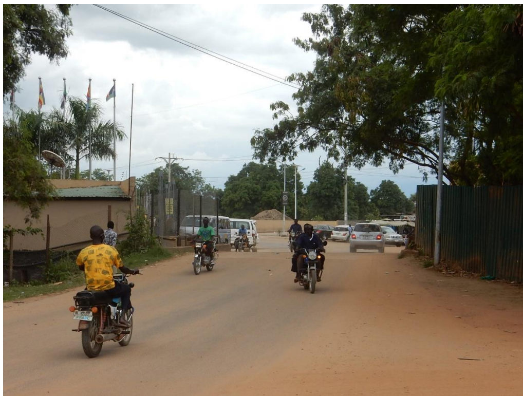
道路上始点側（左岸側）から望む
