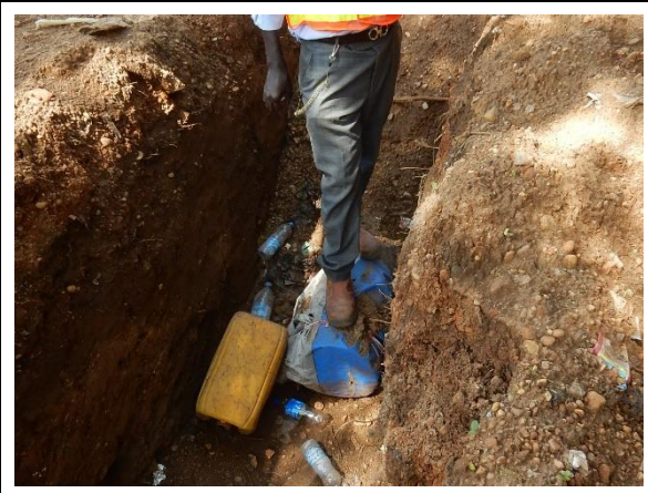
No.7 橋で設置作業中のパイプ (φ300)
