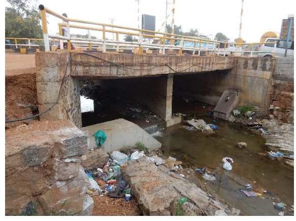
No.22 の橋梁の現況
