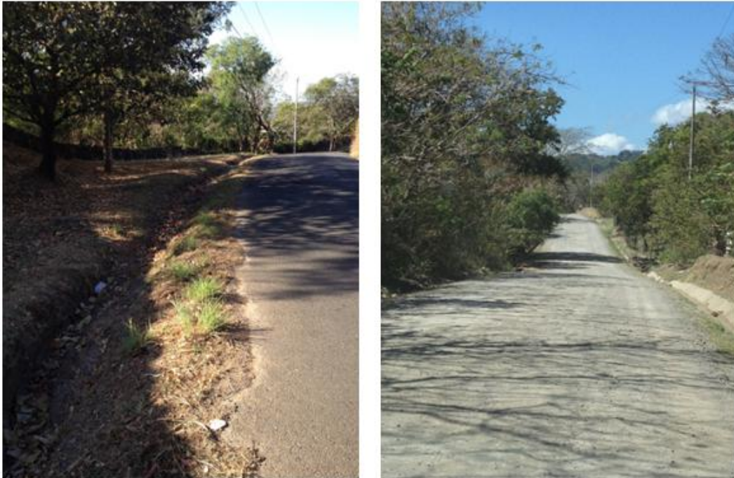
182 Fotografía No. 5.3.37 Ejemplo de los drenajes a los lados de los caminos.
